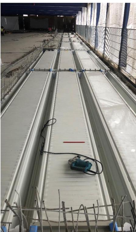
Inzwischen ist die Fertigstellung der Betondecke in Ebene 5 erfolgt. In die wieder fixierten Schalen ist Armierungsstahl eingebaut worden. Diese Elemente sind wieder mit Beton ausgegossen. In ca. drei Monaten können die ausgehärteten Betonelemente dann beschichtet und freigegeben werden. So lange bleibt Ebene 5 gesperrt.
