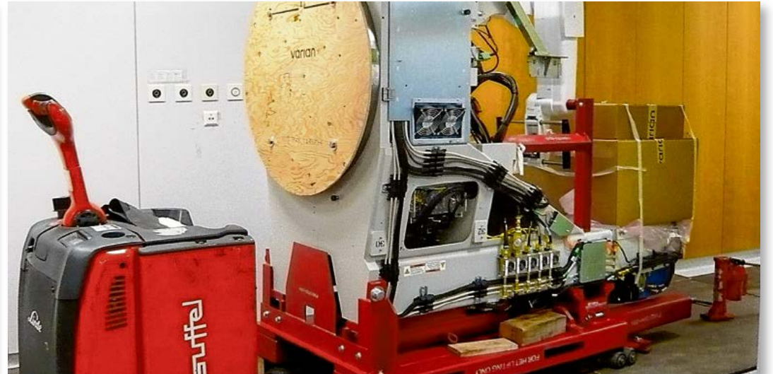
Die Gantry des neuen Linearbeschleunigers auf dem Weg zu ihrem Standort.
