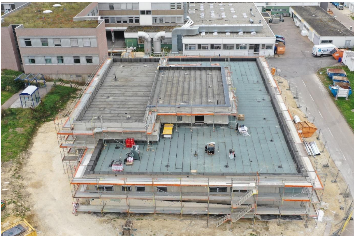
Rohbau der neuen Strahlenklinik
