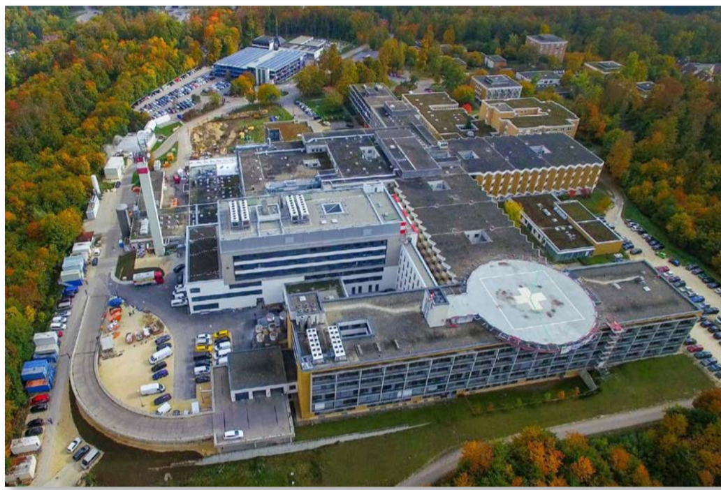
Die Außenarbeiten am Haus K (Bildmitte) sind fast abgeschlossen, derzeit läuft der Innenausbau auf Hochtouren.
