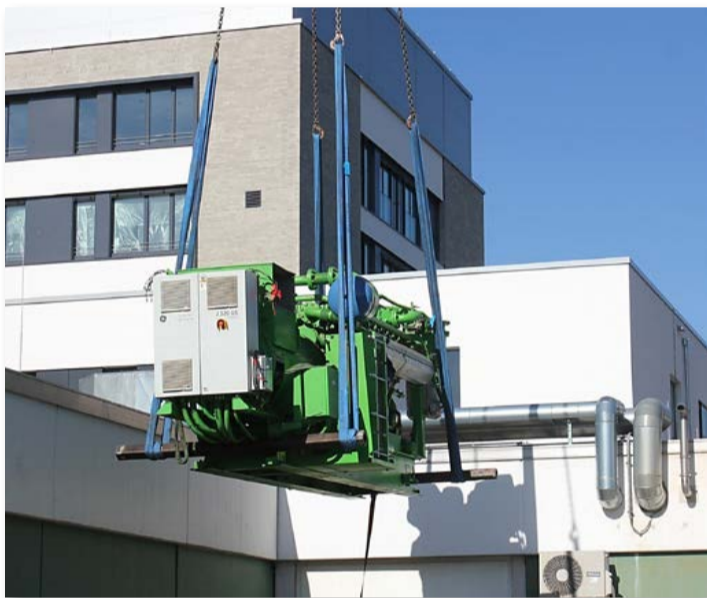
Das mehrere Tonnen schwere System am Haken.
