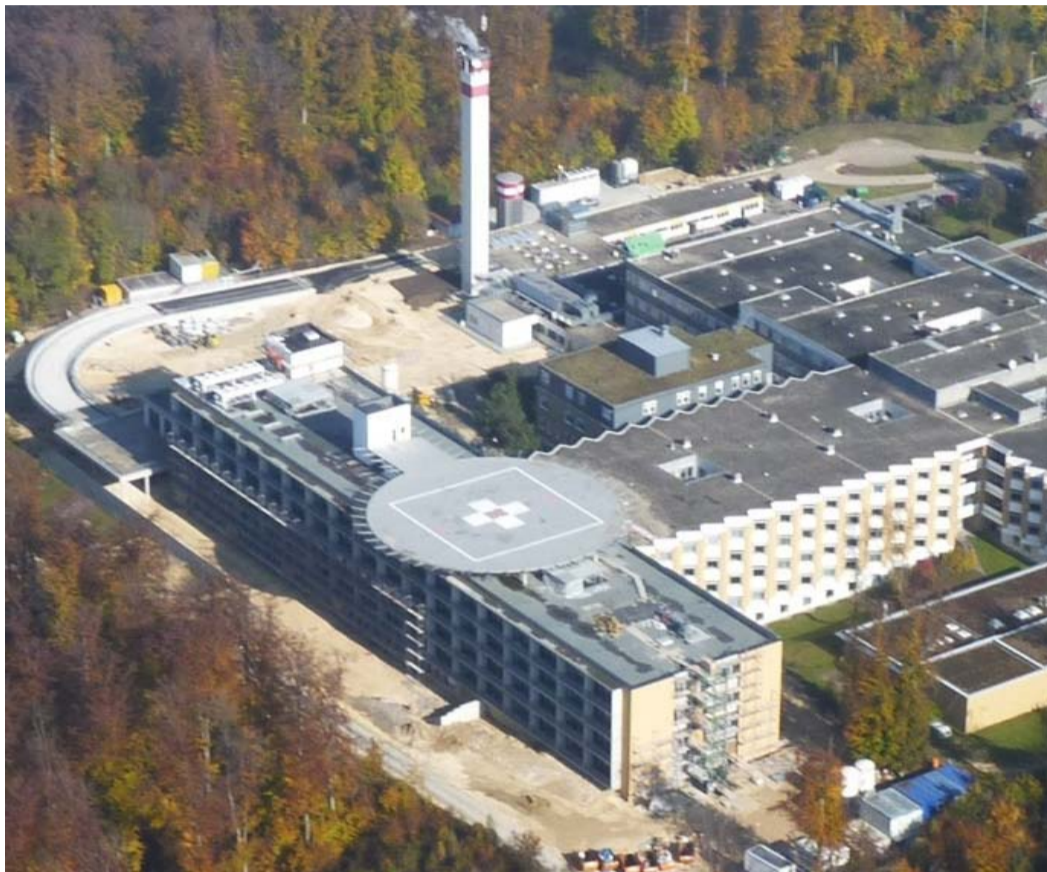
Markantes Detail - die Hubschrauberlandeplattform auf dem Dach des Bettenhauses C
