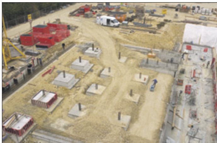
Blick auf die Baustelle des Bettenhauses C.
