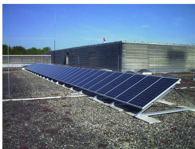
Im Juli 2001 wurde auf der Dachfläche des Behandlungsbaus eine Solaranlage (Photovoltaik) installiert. Hierbei handelt es sich um 4 Modulstränge mit 9 Einzelmodulen (je Modul ca. 110 W). Die Gesamtleistung der insgesamt 36 Module beträgt ca. 4 kWp. Die Einspeisung des erzeugten Stroms erfolgt in das öffentliche Netz der Stadtwerke Heidenheim und wird vergütet.
