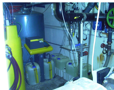
Lagerung von Gefahrstoffen
